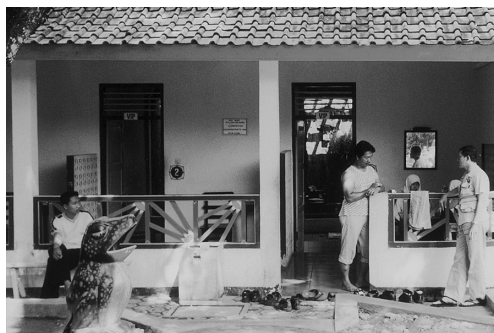
写真 4 浴室の表側、浴室の前にベランダがある
